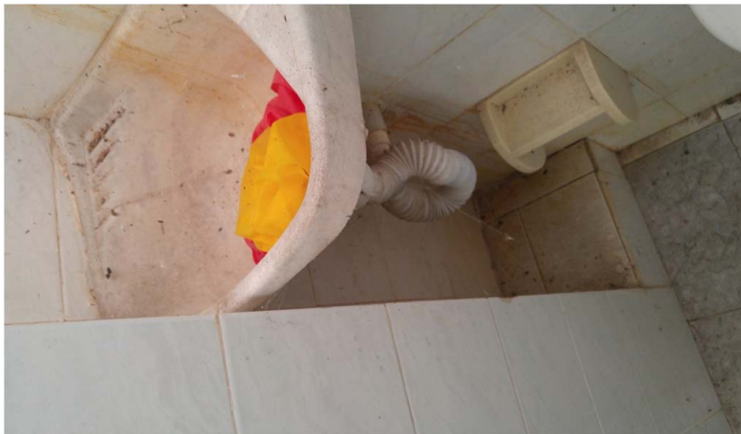
* Banheiro da recepção.
