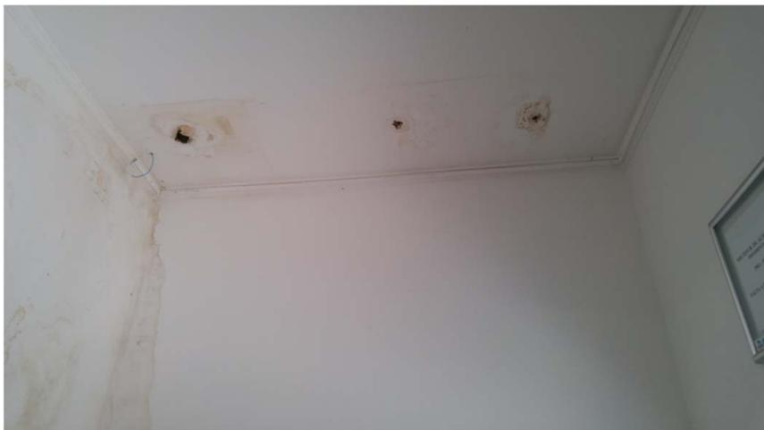
\* Teto de gesso com infiltração e danificados
