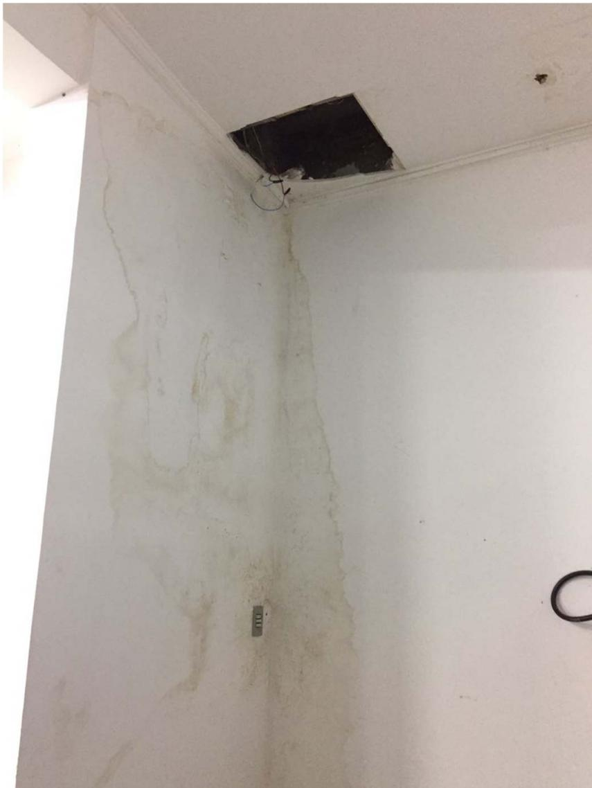
\* Paredes com infiltração e teto de gesso quebrado.
