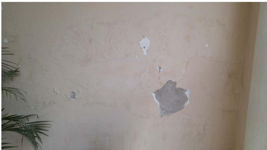
\* Paredes do pátio da Câmara descascadas.
