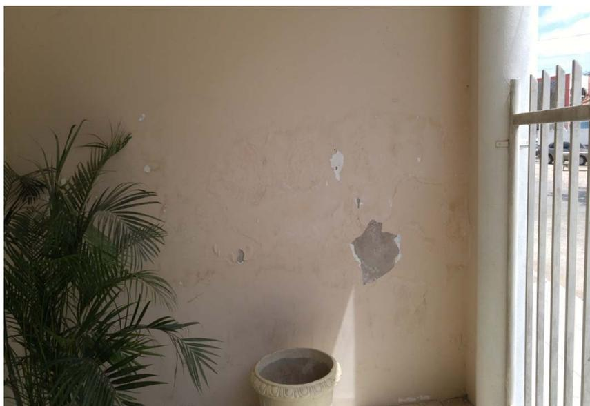
\* Paredes do pátio da Câmara com infiltração.
